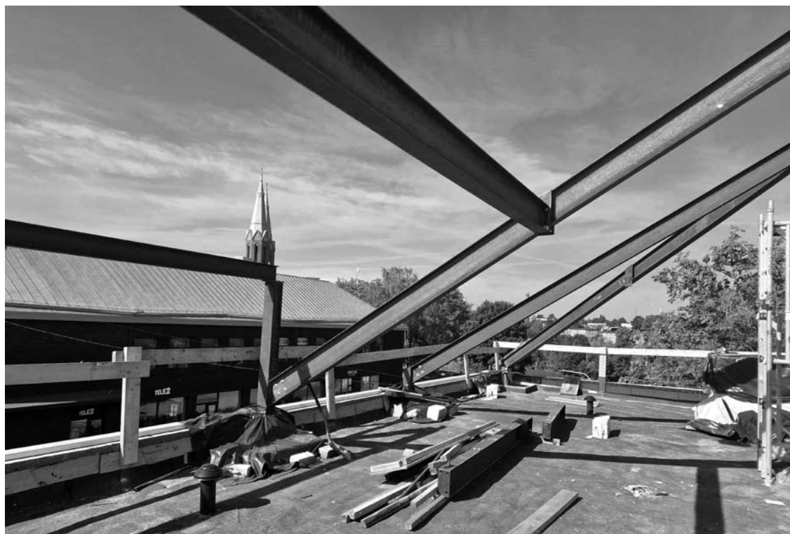
Įrengiant mansardinį pastato aukštą, formuojamas šlaitinis stogas.
